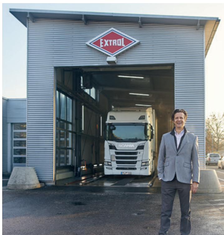
Christian Schulz, geschäftsführender Gesellschafter der Extrol Mineralöle Schulz GmbH, vor der energieautarken LKW-Waschstraße im Gewerbegebiet Haid in Freiburg.
